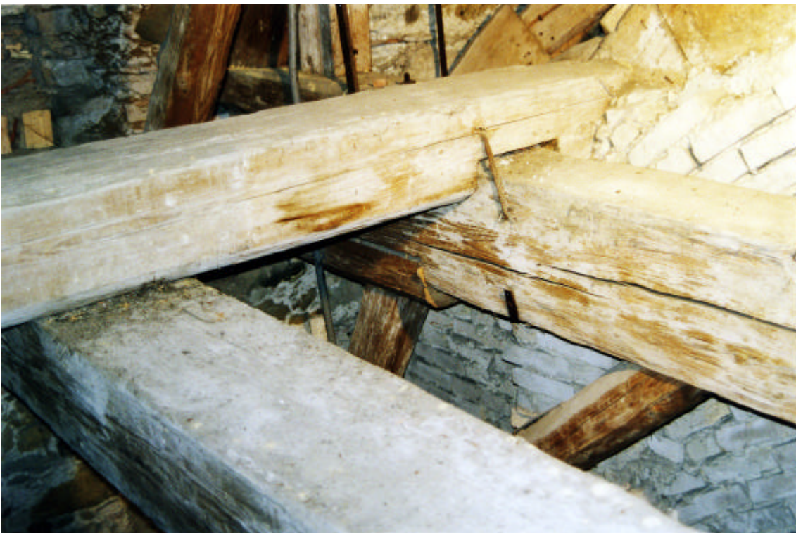
Foto 2: Auflager von Binder 15 (Nordseite)
