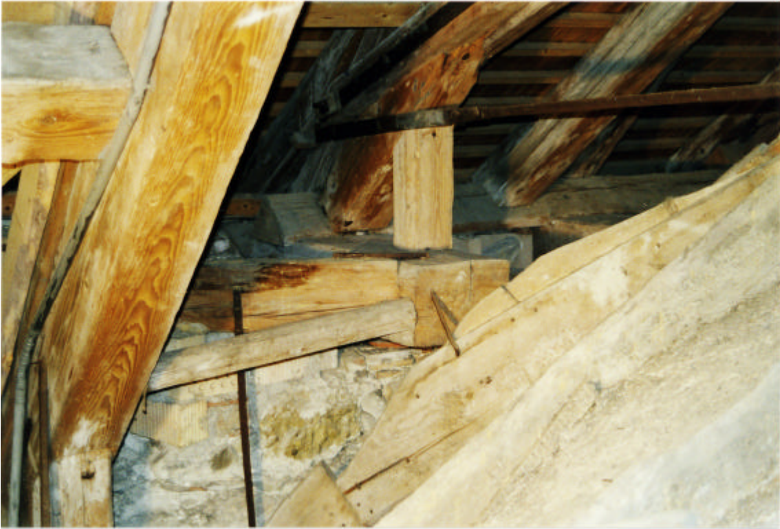
Foto 4: abgetrennte Zugbalken mit Stahlzugband (Nordseite)
