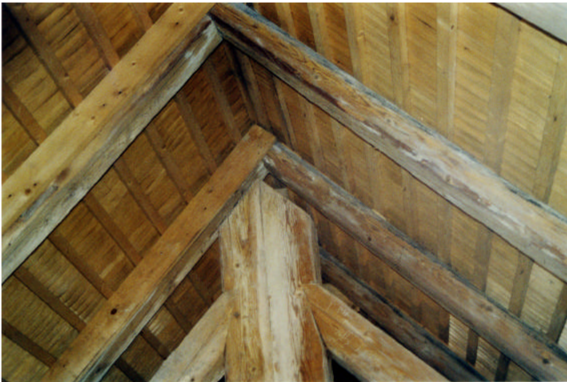
Foto 5: abgeänderte Dachkonstruktion über Galerie
